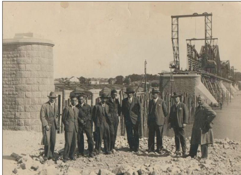
Budowa mostu. Inż. W. Orłowski pierwszy z lewej.
